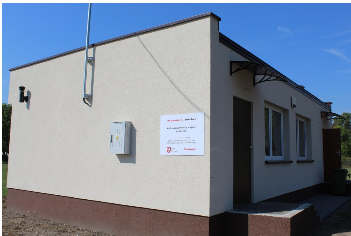
fot. Modernizacja świetlicy wiejskiej w Kobylinie
