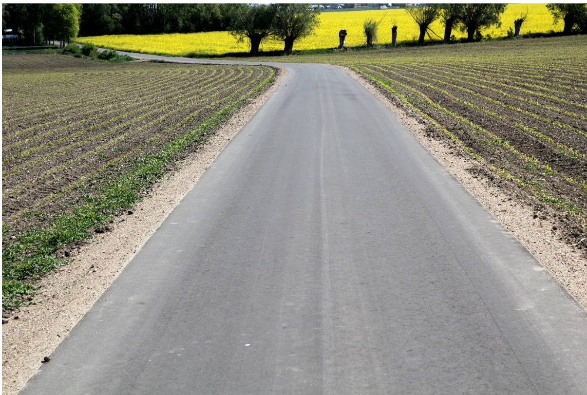
fot. Przebudowa drogi gminnej w Rembówku
