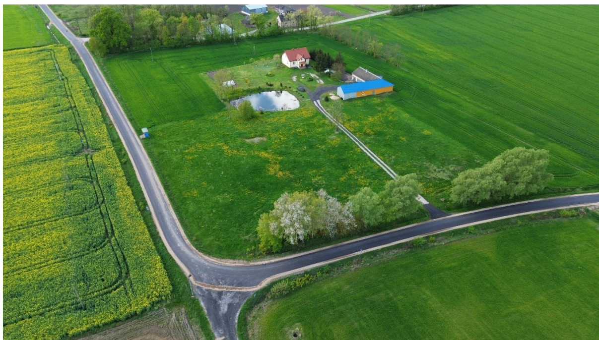
fot. Remont drogi gminnej Łęki - Pajewo-Króle Źródło: Urząd Gminy w Opinogórze Górnej
