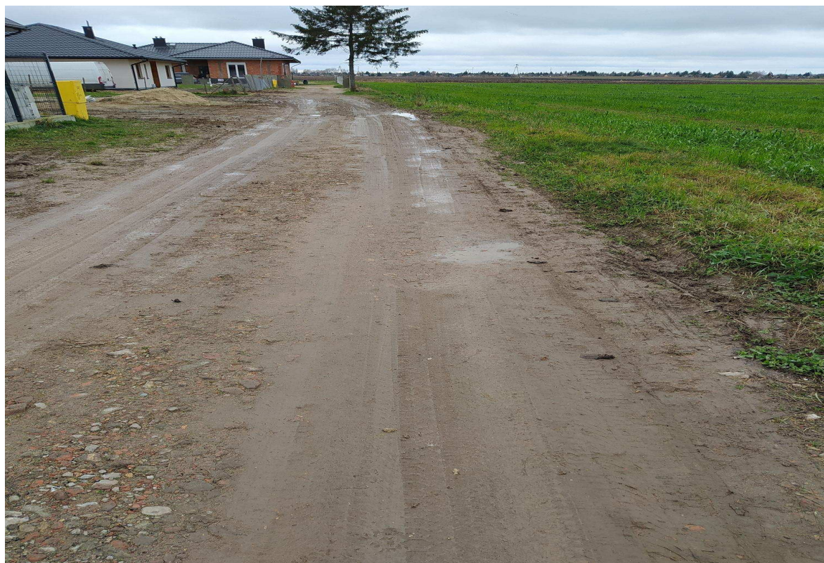
Fot.2. Widok na wydzieloną drogę w miejscu projektowanej kanalizacji . Fotografia Pracowni Projektowej wykonana w listopadzie 2020 r .
