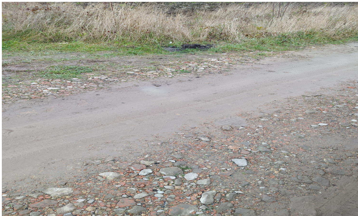
Fot.1. Widok na drogę w miejscu włączenia do sieci kanalizacyjnej „ks200” . Fotografia Pracowni Projektowej wykonana w listopadzie 2020 r .
